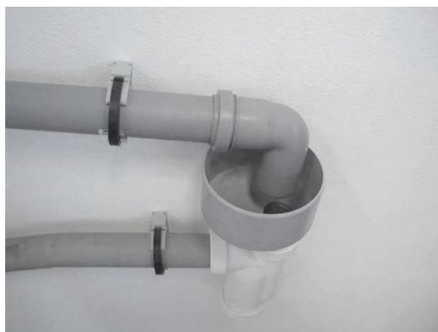
Bild IV.13: Schema Anschluss Abwasserleitung mit offenem Trichtersiphon
